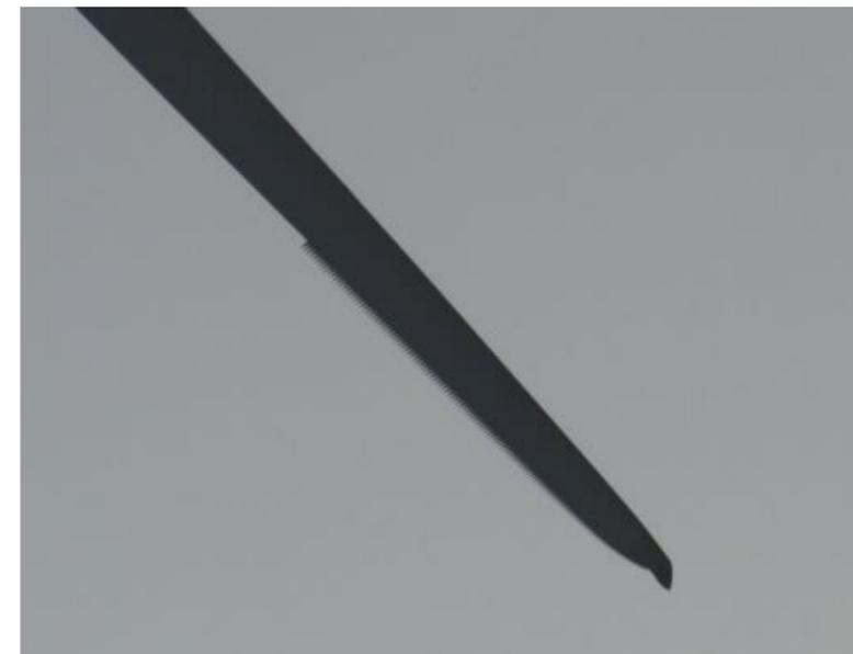
Photographie 3 Exemple de serration mise en place sur un parc en Bretagne
